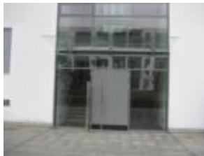
Dørtelefoner og adgangskontrol
