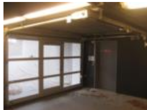
Port til p-kælder
