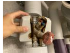
Statisk cirkulationsventil i varmecentral
