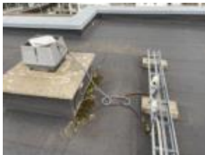
Udsugningsventilator
