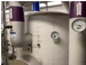
Varmtvandsbeholder
