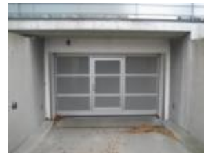
Port til p-kælder
