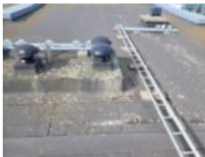
Tagflade på bygning 31
