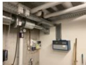
Automatik for olie- og benzinudskiller
