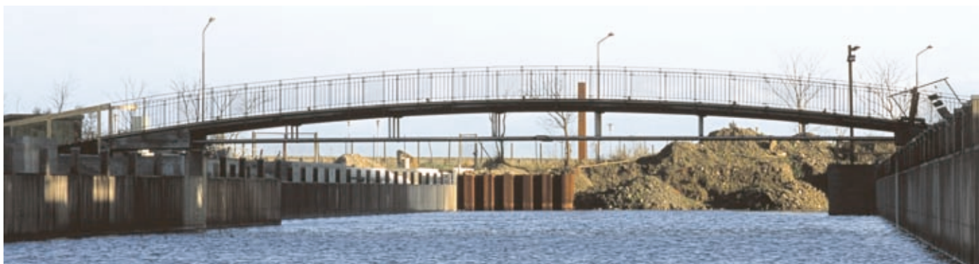
Figur 2. Stibroen – med Stenhavn byggepladsen i baggrunden.
